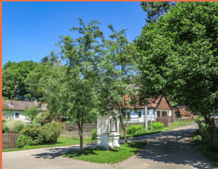
Při vjezdu na náves v Bříšejově na Sedlčansku stojí kaplička z 90. let 20. století, která byla vybudována na místě staré. Stavbu doprovázejí dva krátkověké jeřáby ptačí. +
